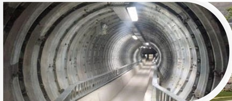
Electrificación Líneas 3 y 6 Metro de Santiago (Chile)
