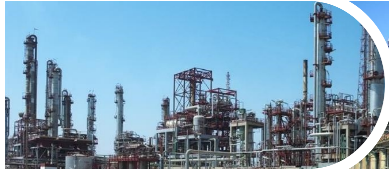
Refinería Huelva (España)
