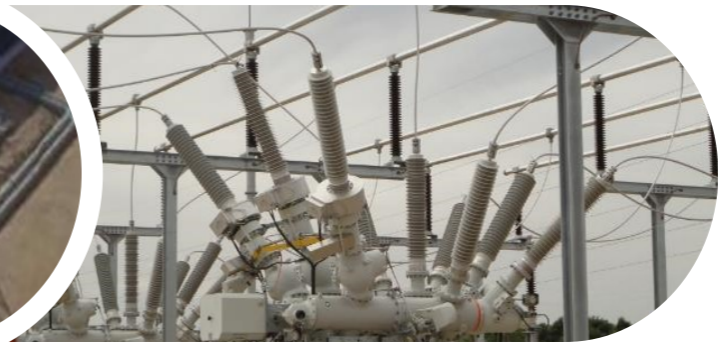
SE Híbrida 132kV Pabellones (España)
