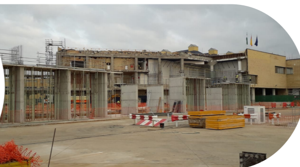
Remodelación Terminal Pasajeros Aeropuerto de Sevilla (España)
