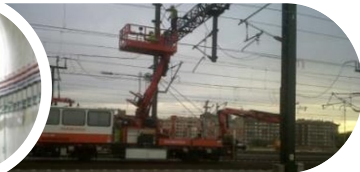
Mantenimiento LAV Madrid-Barcelona-Frontera Francesa (España)
