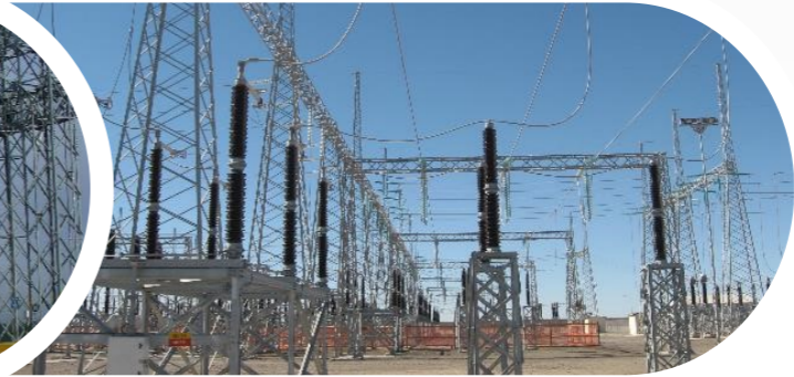
Subestación 220 kV Sierra Gorda (Chile)
