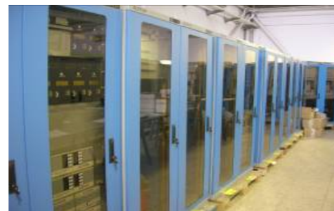
Paneles de control Tranvía de Jerusalén para Alstom Transporte
