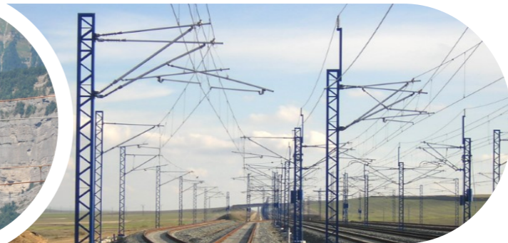
Mantenimiento Alta Velocidad Antequera-Granada (España)
