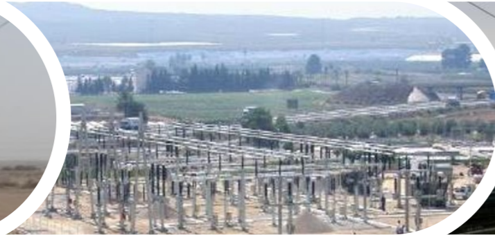
Catenaria y SSEE Líneas de alta velocidad (España)
