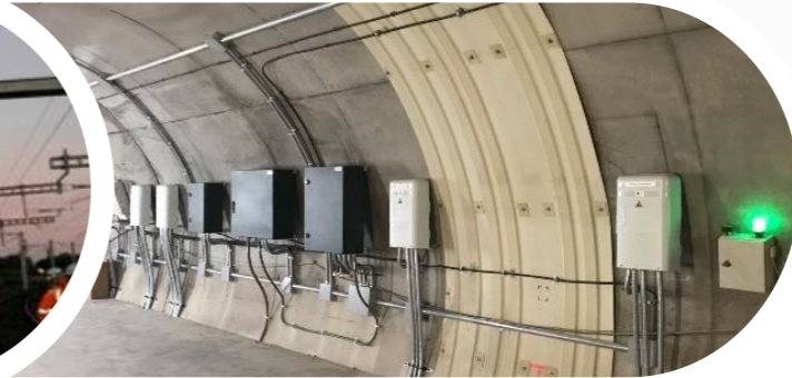
Sistemas de telecomunicaciones y seguridad Ave La Robla-Pola de Lena (España)
