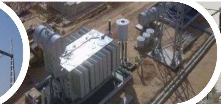
SSEE 400kV en Zawiya, Sirte, Janzour y Benghazi Sur (Libia)
