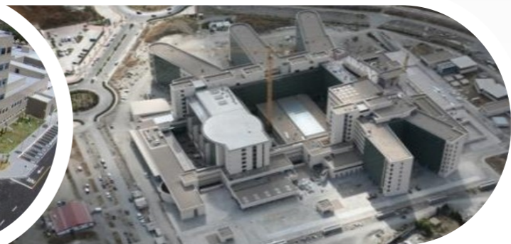
Hospital Campus de la Salud Granada (España)
