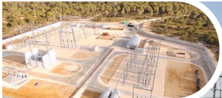
SE 225/63 kV de Castellet (Francia)
