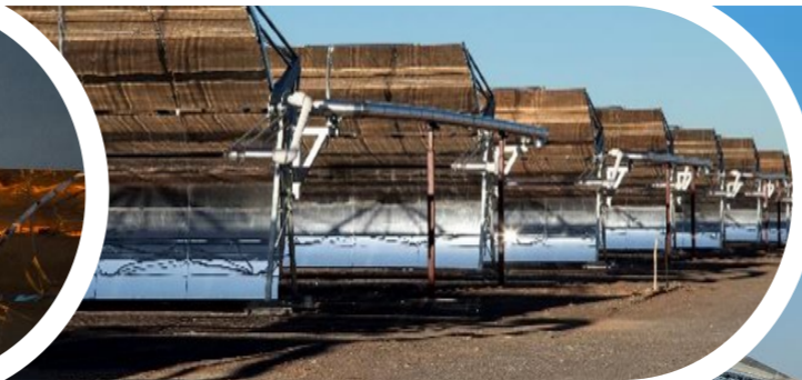
Kaxu Solar One CCP (Sudáfrica) - 1.200 uts
