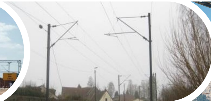
Renovación catenaria Landas-Valenciennes (Francia)
