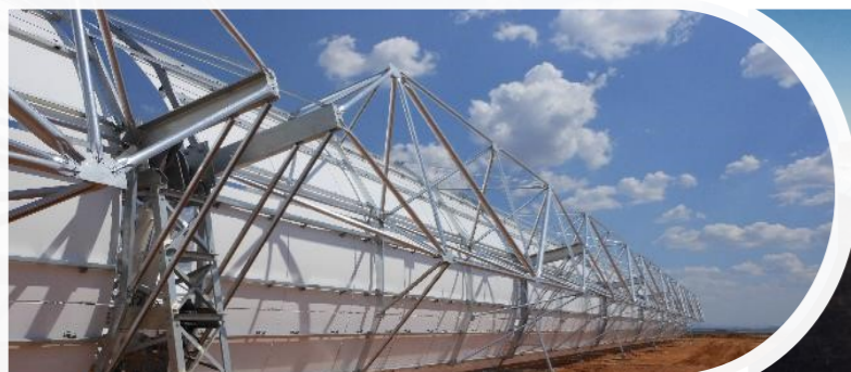
Solabén Solar CCP (España) – 2520 uts
