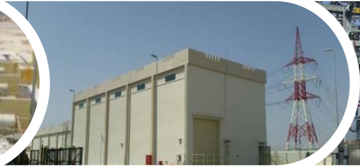
Subestación Al Dreez 132/33 kV (Omán)
