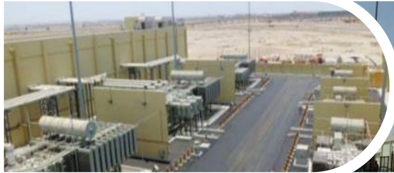
SSEE GIS 380/132/13.8kV Riyadh y Jeddah (Arabia Saudí)
