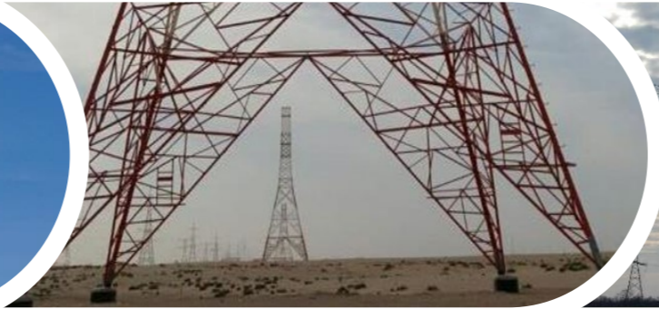
TL Faya-Shamkha 400 & 220 kV (UAE)
