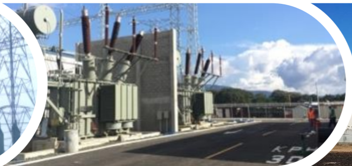
230/34,5 kV GIS SS Jaco & Coyol (Costa Rica)
