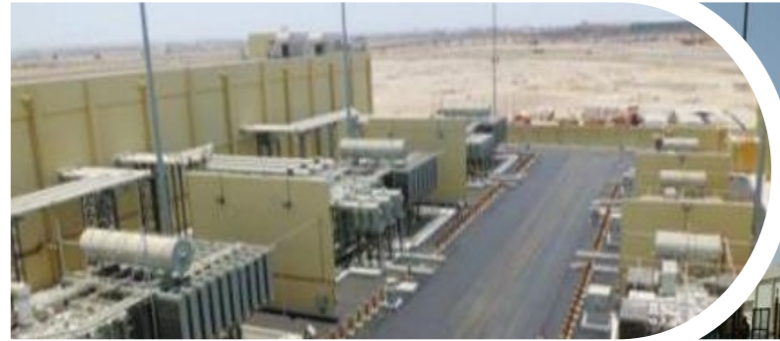
380/132/13.8kV GIS SS in Riyadh & Jeddah (Saudi Arabia)
