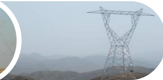
500 kV TL Chilca-Marcona-Montalvo - ATS (Peru)
