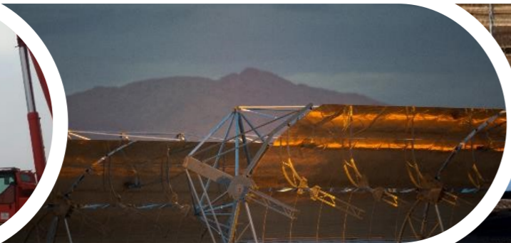
Mojave Solar CCP (USA) - 700 uts
