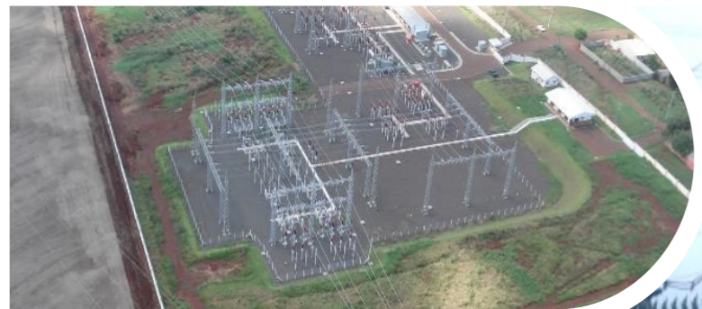
SE Foz Foz do Iguaçu 230/138kV (Brazil)
