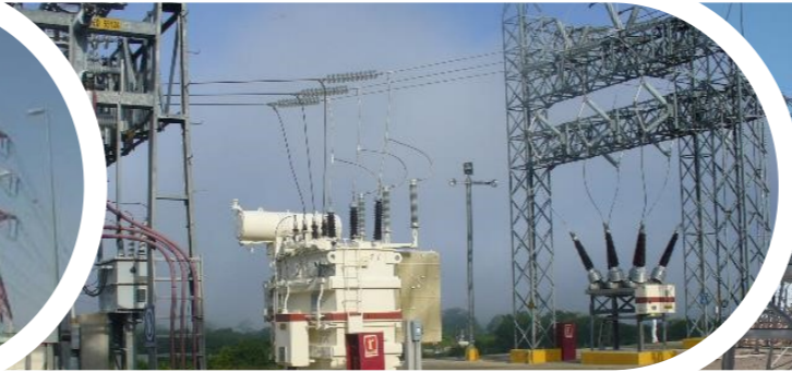
400/138kV SS Transformacion del Noreste (3er Phase) (Mexico)
