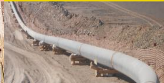
Acueducto Tierra Amarilla Chile
