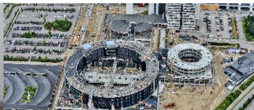
Instalaciones electromecánicas Dinamarca
