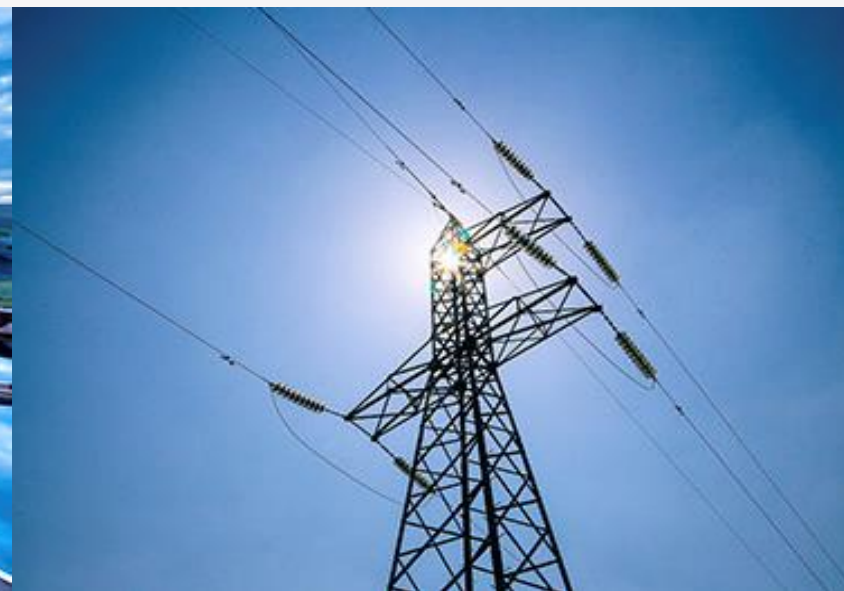
Transmisión e Infraestructuras
