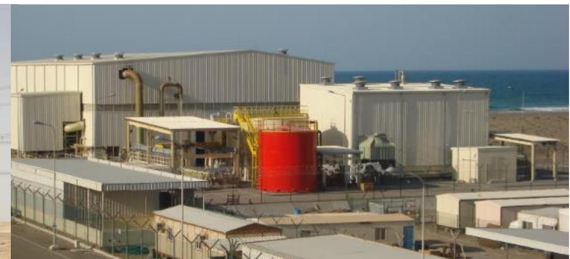
Desaladora de Barka Omán
