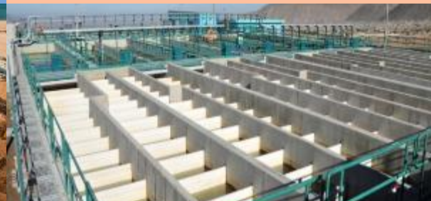
Sistema Abastecimiento y Saneamiento Cunene Angola
