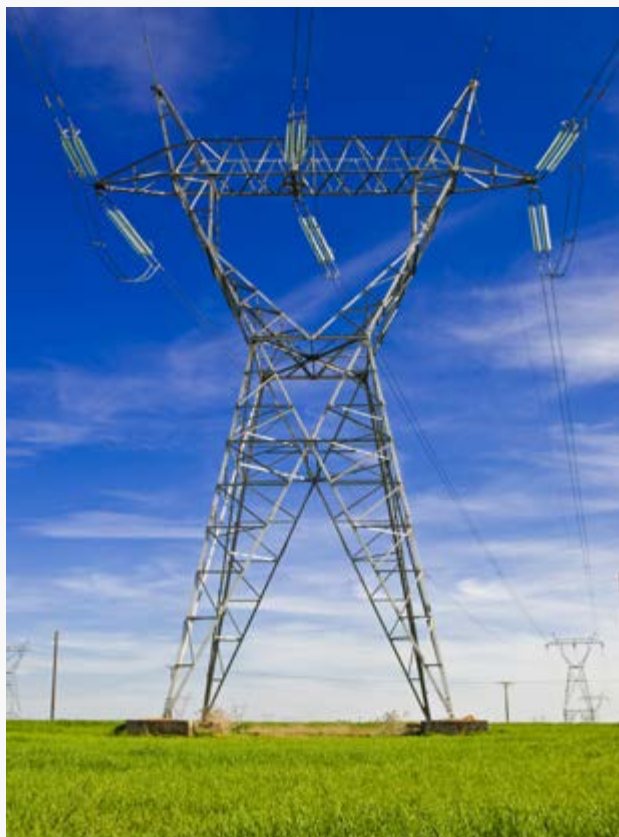
► Abengoa lleva 40 años en México, durante los que se ha centrado principalmente en los sectores de transmisión y generación de energía, entre otros.
