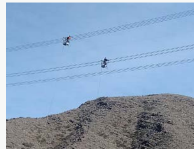
► Colocación de espaciadores en el tendido de línea de 500 kV, en la provincia de San Juan.
