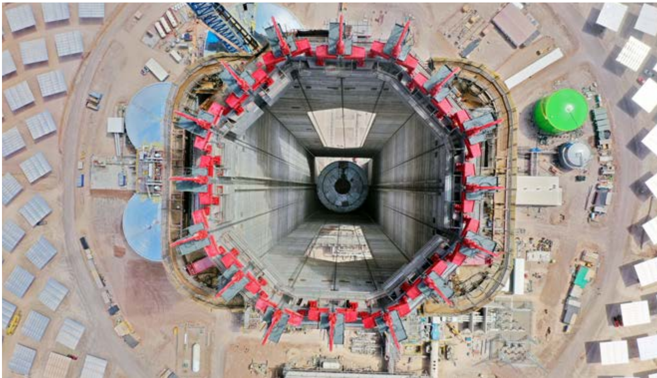
► Momento del izado del receptor de la planta termosolar de Cerro Dominador.
