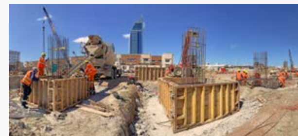
► Abengoa se adjudicó nuevas obras civiles en una planta de celulosa de la empresa UPM.
