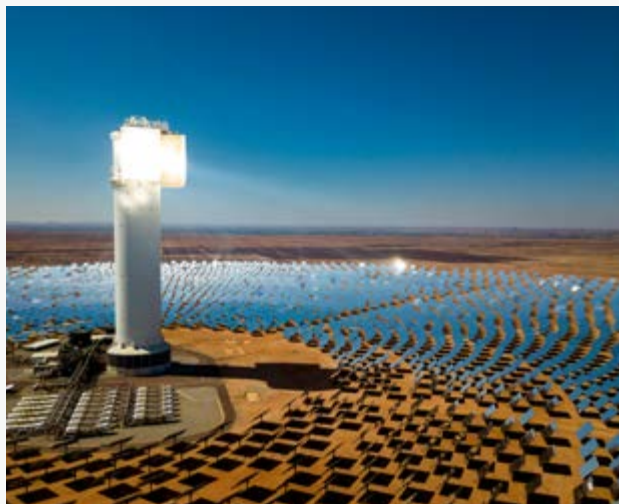
► La planta termosolar Kasi Solar One, construida por Abengoa, en plena operación.
