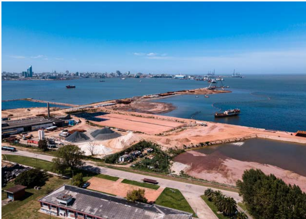
► Trabajos de Abengoa en la Terminal Pesquera Puerto Capurro.
