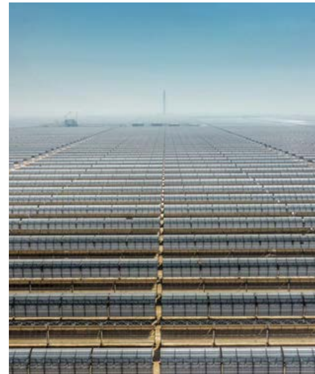
► Abengoa ha finalizado la construcción de un campo solar de colectores cilindroparabólicos para el complejo solar más grande del mundo, en Dubai.
