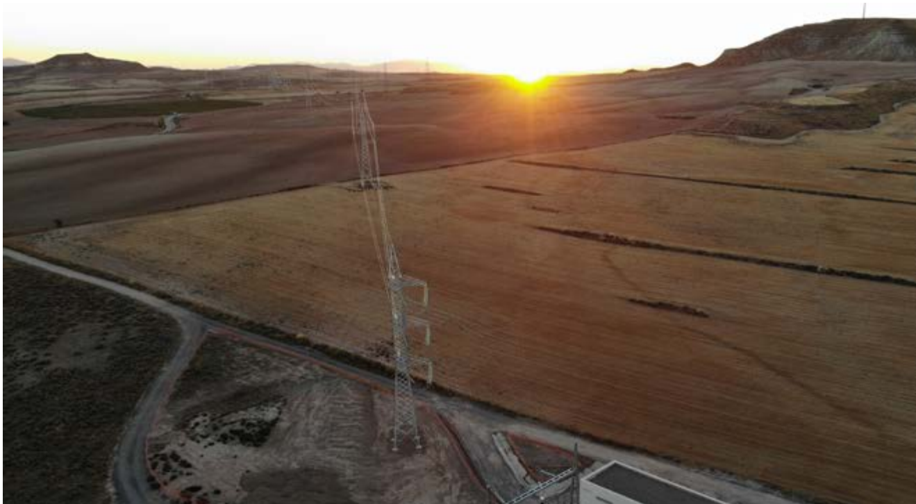
► Torres de telecomunicaciones para la línea de transmisión Los Belos (Teruel – Zaragoza), producida en la fábrica de estructuras metálicas, Eucomsa.
