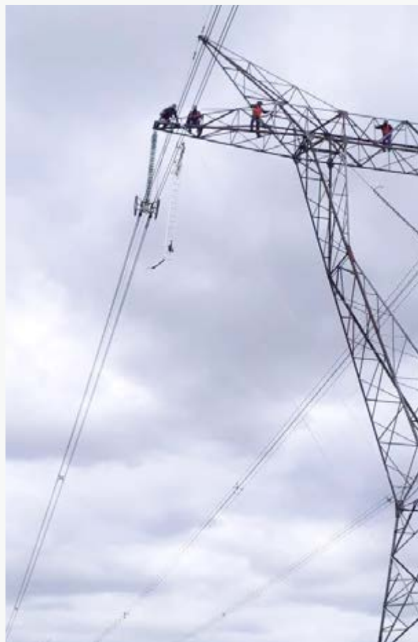
► Trabajos de mantenimiento en una línea existente de 550 kV.
