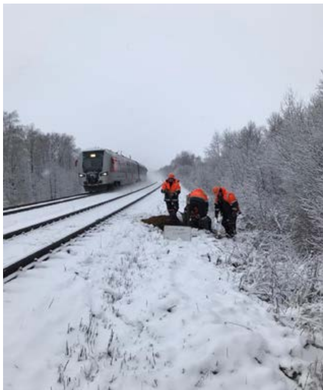
► Trabajos de ingeniería para el proyecto de electrificación ferroviaria Vilnius-Klaipeda de Lituania.
