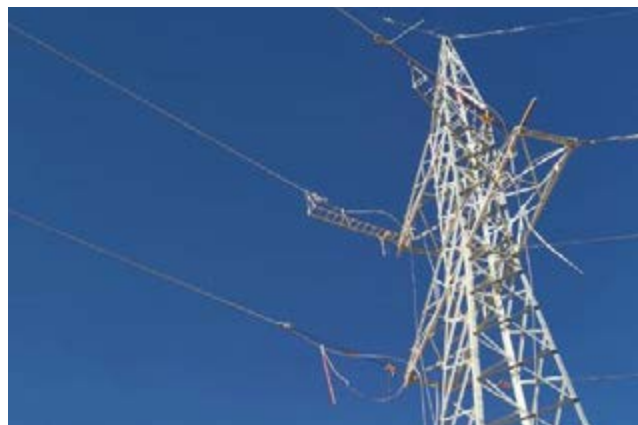
▶ Trabajos en la línea de evacuación de un parque eólico en Chile.
