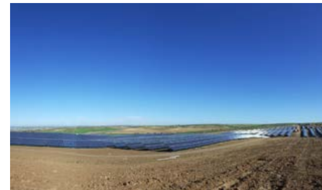
► Abengoa desarrolla la ingeniería constructiva de una planta fotovoltaica en Barciencia (Toledo).
