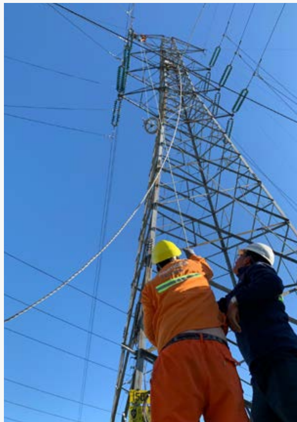
► La compañía finalizó el pasado año el tendido de cable de fibra óptica tipo OPGW (Optical Ground Wire) en una línea de 150 kV.
