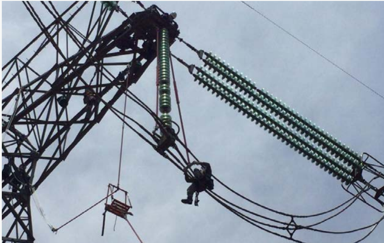
► Abengoa ha creado un área de mantenimiento en líneas vivas (energizadas).
