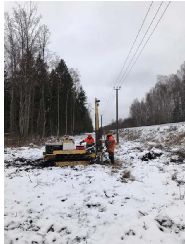
► Abengoa trabaja en un proyecto de electrificación ferroviaria en Lituania que conectará el país de este a oeste.
