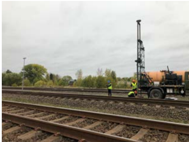
► Abengoa es referente internacional en las actividades de catenaria, subestaciones, comunicaciones e instalaciones auxiliares.
