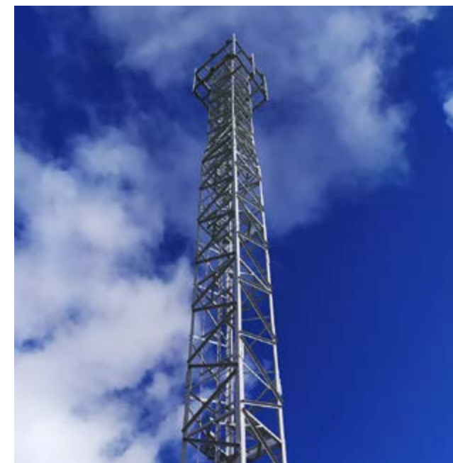
► Fabricación de torre de telecomunicaciones para telefonía móvil en España.
