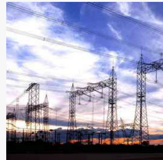
► Subestación de 500 kV en Brasil.
