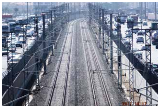
► Vía de la línea de alta velocidad La Meca – Medina.
