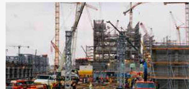
► Trabajos en las torres de transmisión en las inmediaciones de la planta de generación de biomasa de Arauco.
