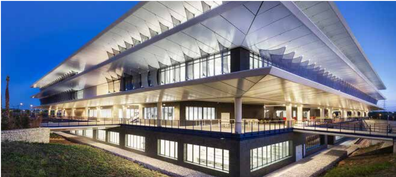
► En España, Abengoa ha participado en importantes proyectos de infraestructuras por toda la península. En la imagen, la nueva sede de la Universidad de Loyola en Dos Hermanas (Sevilla).
