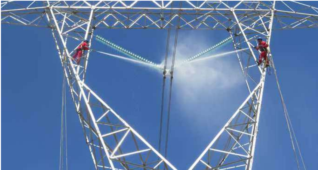
► Trabajos de labor y mantenimiento en una línea de transmisión.
