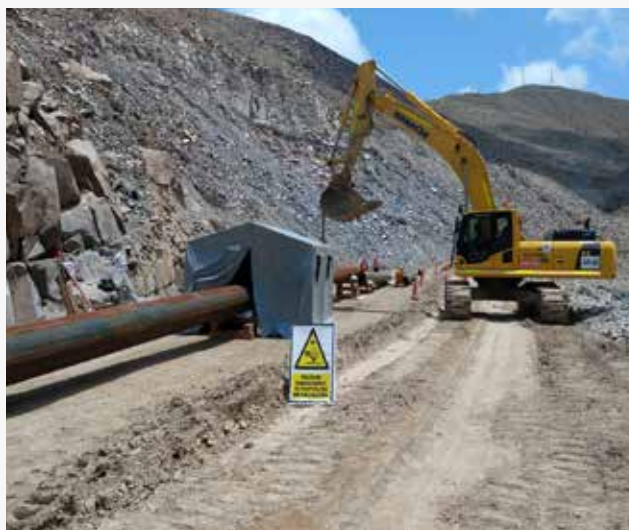
► Trabajos de Abengoa en el proyecto Incapuquio, en Toquepala.
