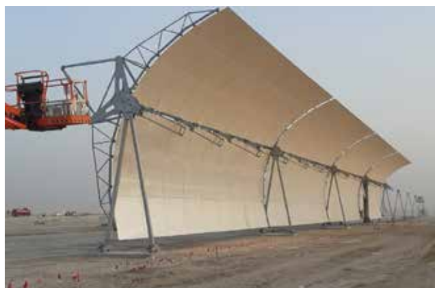
► Uno de los colectores cilíndricos del campo solar de la fase IV del Al Maktoum Solar Park.
