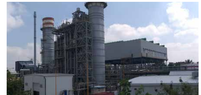
► Planta de cogeneración eficiente A3T, en México.
