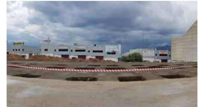
► Inicio de la obra (cimentaciones) de Mutua Universal en Málaga.
