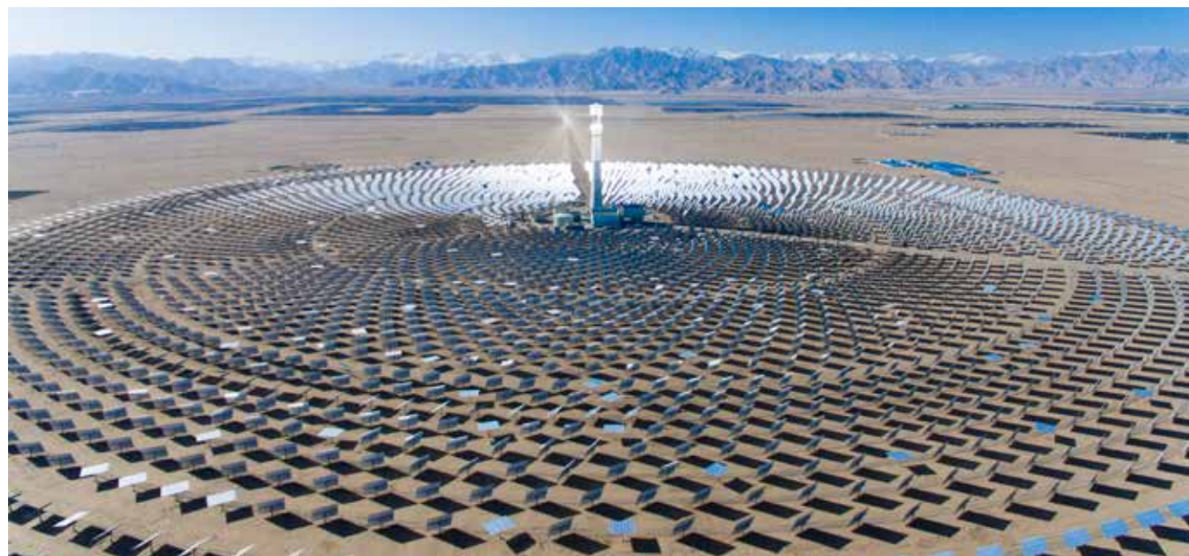
► Planta termosolar de torre Luneng Haixi.
