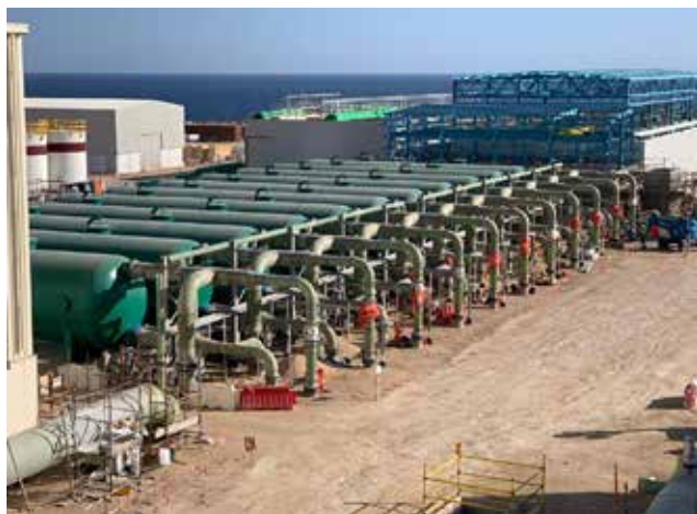
► La planta desaladora que Abengoa construye en Salalah, Omán, funcionará con tecnología de ósmosis inversa.
