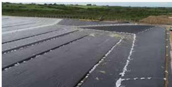
► Proceso de construcción del relleno sanitario en Río Negro.
