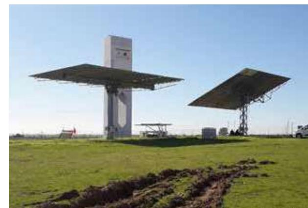
► Detalle de heliostatos en Pontones.
