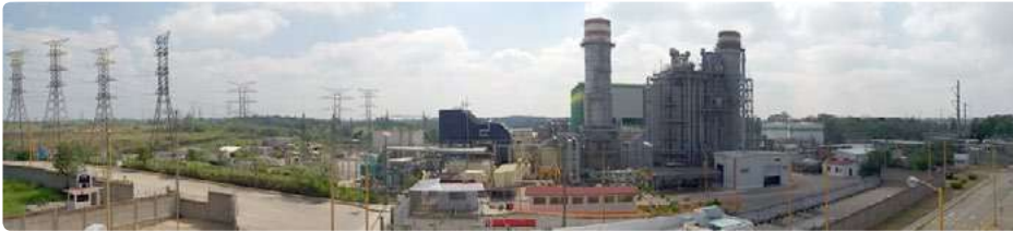
A3T es una cogeneración eficiente que produce energía eléctrica y vapor en México.
