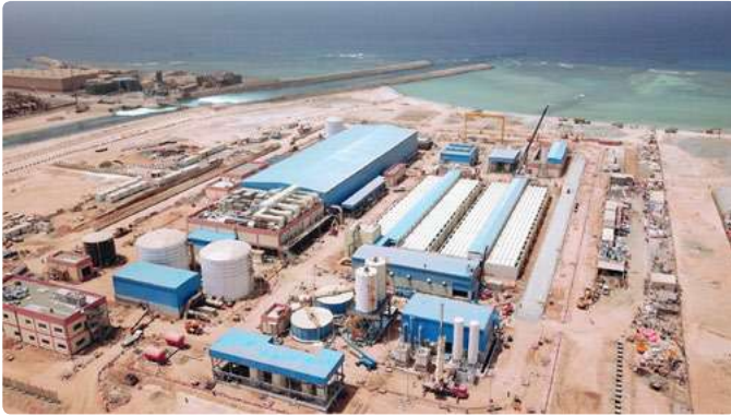
La desaladora de ósmosis inversa que Abengoa construye en el complejo de Shuaibah III ha superado los tres millones de horas sin accidentes con baja laboral.
