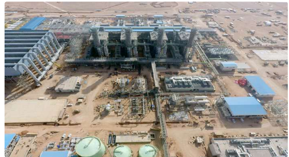
Waad Al Shamal, la mayor central híbrida solar-gas del mundo, en construcción por Abengoa.
