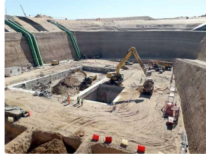
Abengoa desarrolla en Agadir (Marruecos) la mayor desaladora para uso combinado de agua potable y regadío.
