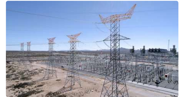
Trabajos realizados en la línea de transmisión asociada al ciclo combinado Norte III.
