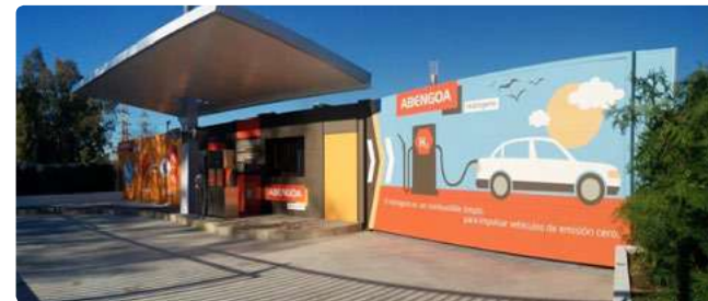
Estación de servicio de hidrógeno.
