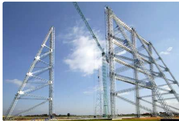
Ensayo de torre de alta tensión en estación de ensayos de Abengoa.
