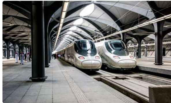
Estación del AVE Meca-Medina.
