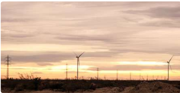
La compañía terminó la línea de alta tensión de 132 kV para el parque eólico Aluar.
