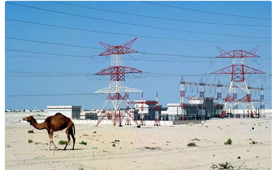
Puesta en operación de la línea de alta tensión Faya-Shamka en Emiratos Árabes Unidos.
