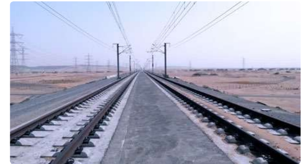
Línea de alta velocidad Meca Medina.
