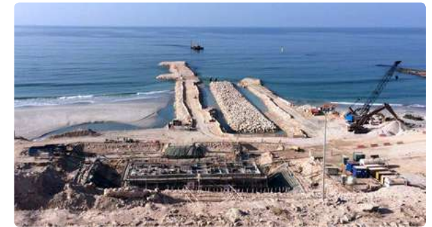
Abengoa continúa trabajando en una planta desaladora en Salalah, Omán.
