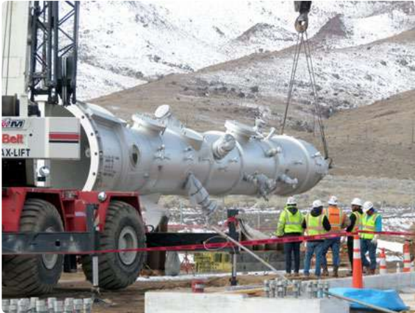
Trabajos en el proyecto Fulcrum Sierra BioFuels
