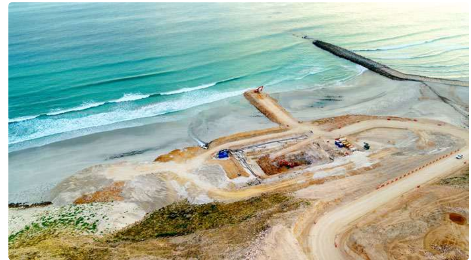
Abengoa construye grandes desaladoras para aportar soluciones sostenibles al ciclo integral del agua.
