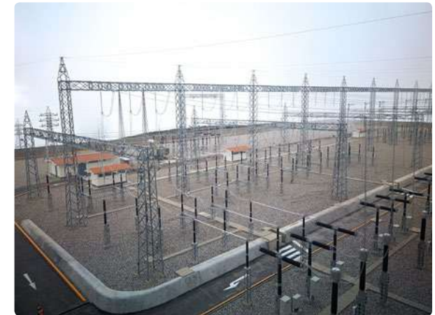
Abengoa está finalizando una subestación de 220 kV en el departamento de Cajamarca.
