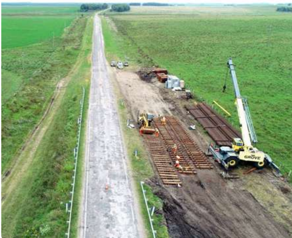
Abengoa se está encargando de la rehabilitación de 327 km de vías férreas.
