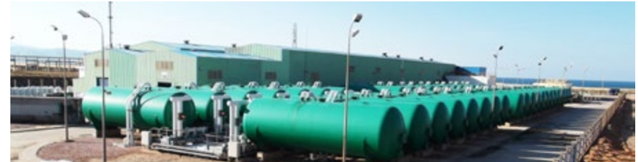
Argelia. Planta desaladora de Skikda
