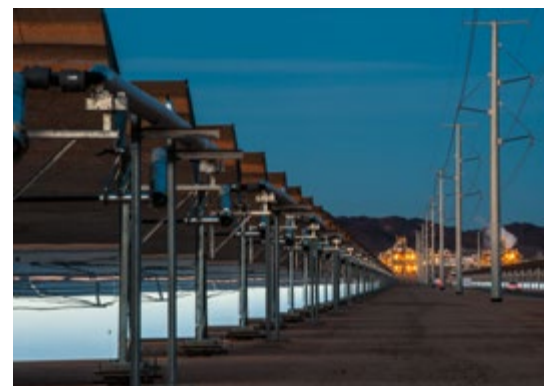
Solana cuenta con un sistema de almacenamiento térmico que asegura la gestionabilidad de la planta
