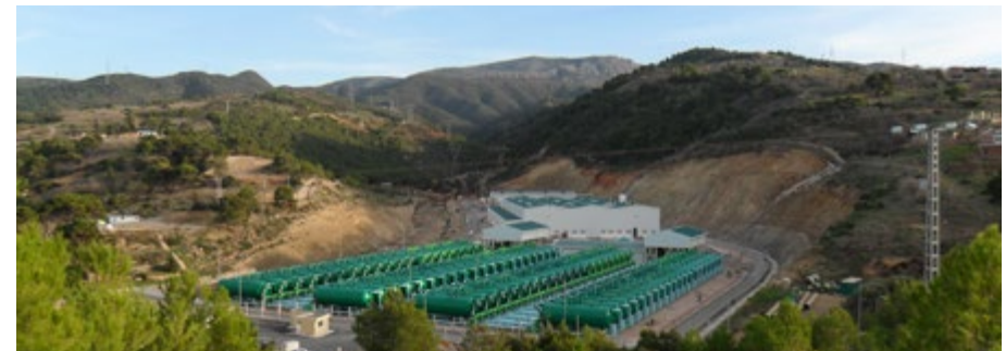
Argelia. Planta desaladora de Honaine
