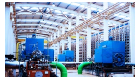
Argelia. Planta desaladora de Ténès
