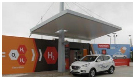
Estación de servicio de hidrógeno
