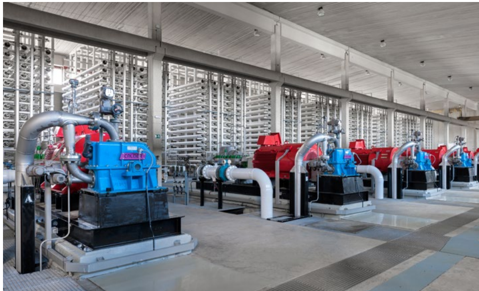
Planta desaladora de Cartagena, España, con una capacidad de 65.000 m 3 /día y tecnología de ósmosis inversa
