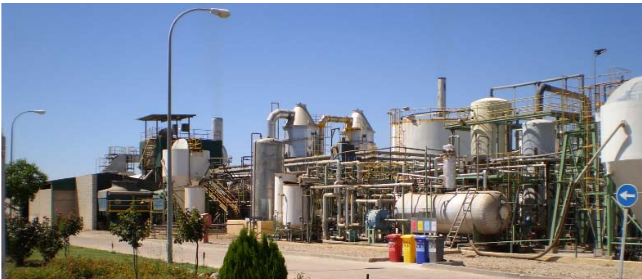
Procesos Ecológicos Vilches cogeneration plant
