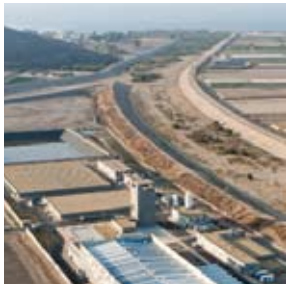
Bajo Almanzora desalination plant (Almeria)
